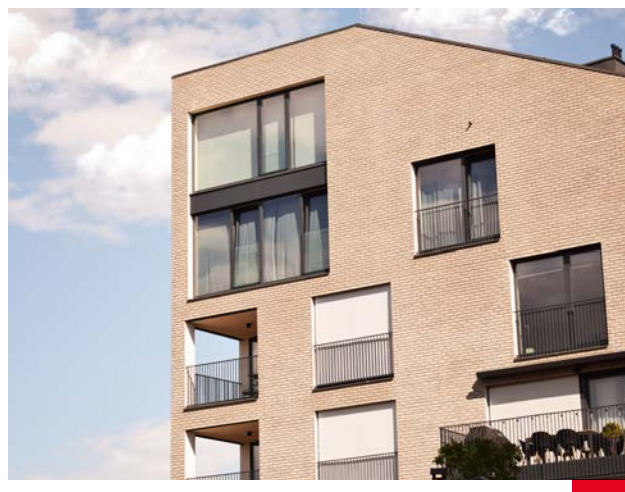
Pana a Baba Praha, Česká Republika Architekt: m4architekti Producent: AYOR development a.s.
